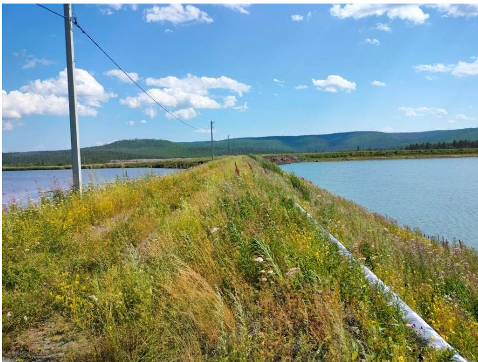
Рисунок Д.3 – Участок изысканий, вид на межсекторное пространство
