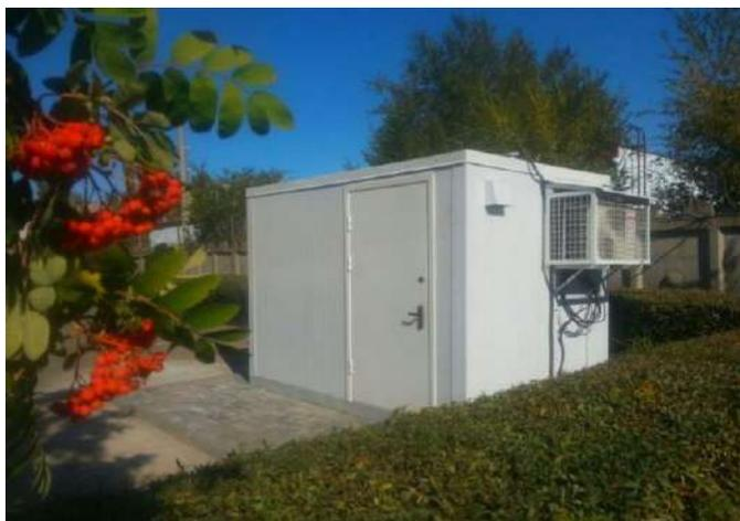
С целью управления и поддержания экологических аспектов на приемлемом уровне, Обществом выполнены работы по проектированию и установке автоматического поста контроля качества атмосферного воздуха на ул. Моцарта, 5 (База оборудования). Данная система позволяет не только получать информацию о воздействии на окружающую среду в онлайн-режиме, но и оперативно принимать плановые и экстренные управленческие решения в области охраны атмосферного воздуха.
