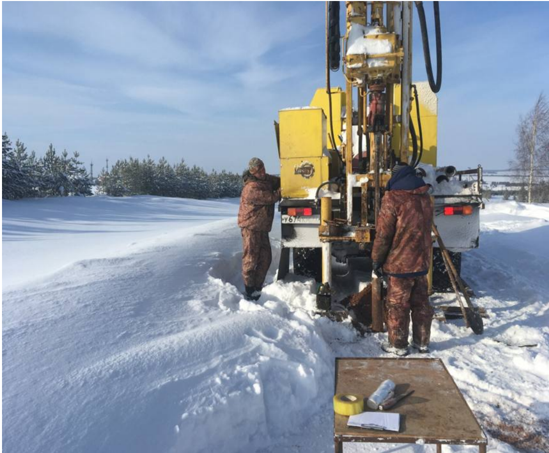
Фото 1- Бурение скважины С-1301, выполнено 05.02.2019 г.
