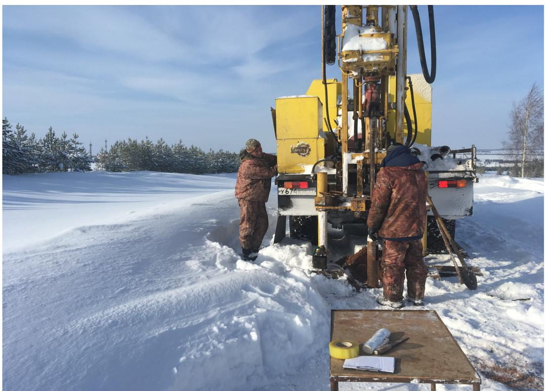
Рисунок 3 – Бурение скважины С-1301 специалистами ООО «Трансэнергострой» буровой установкой УРБ -2А-2.
