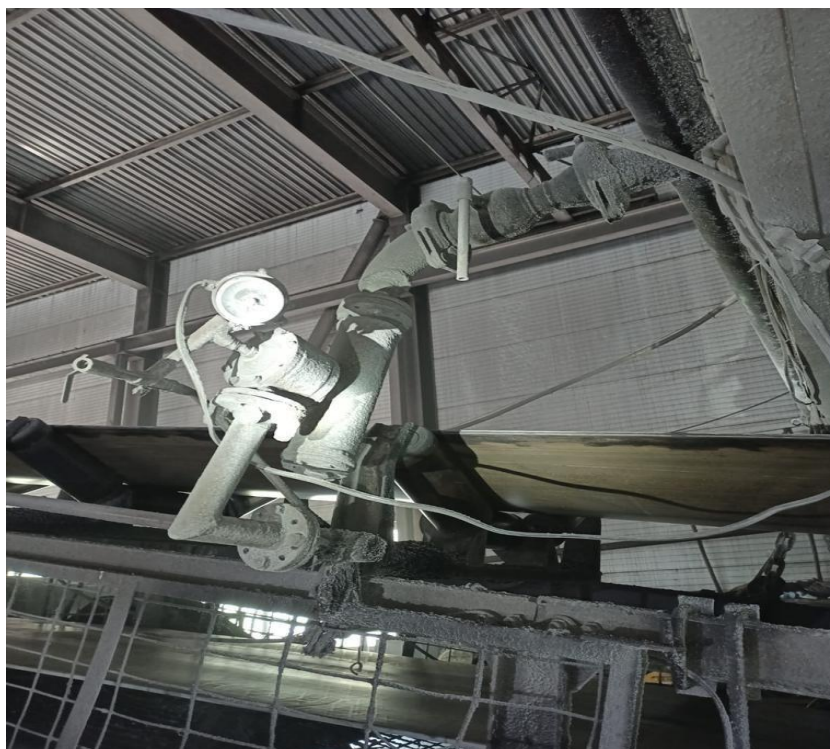
Рис. 5.6.1 Смонтированная секция УАП
