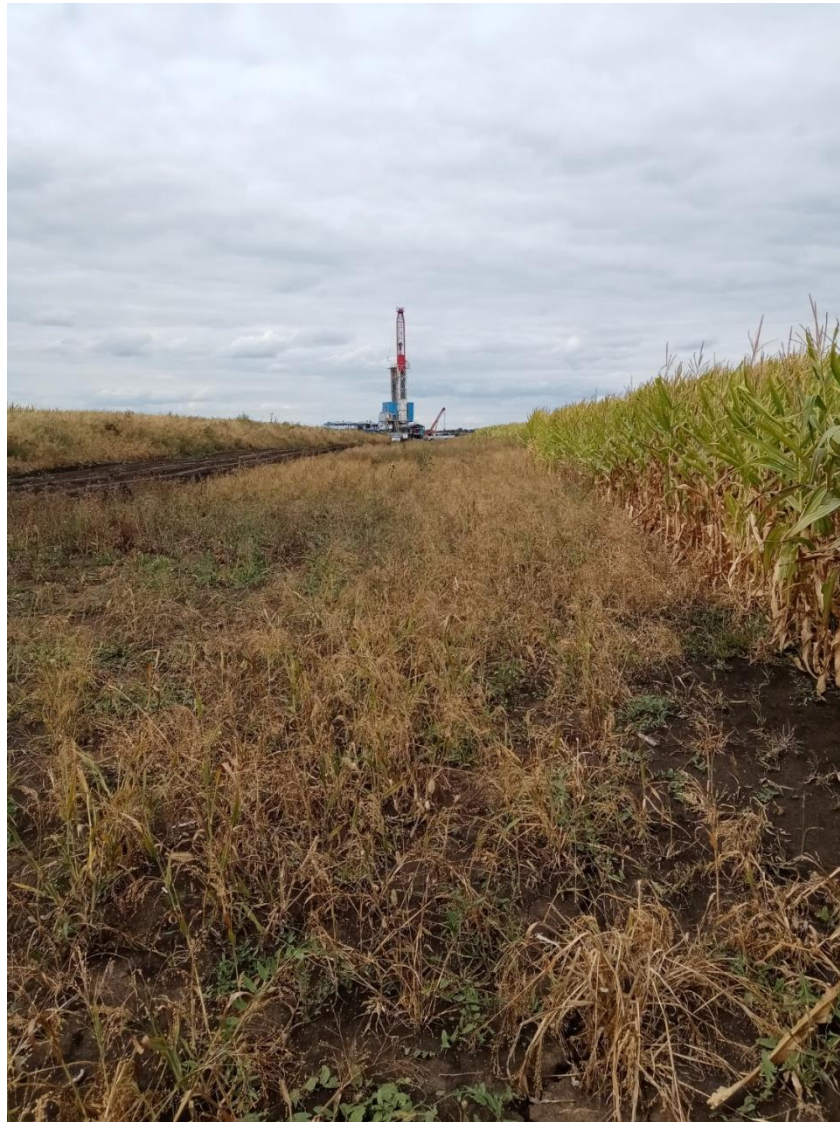
Рис.5.1.6 Буровая установка на площадке скважины №1
