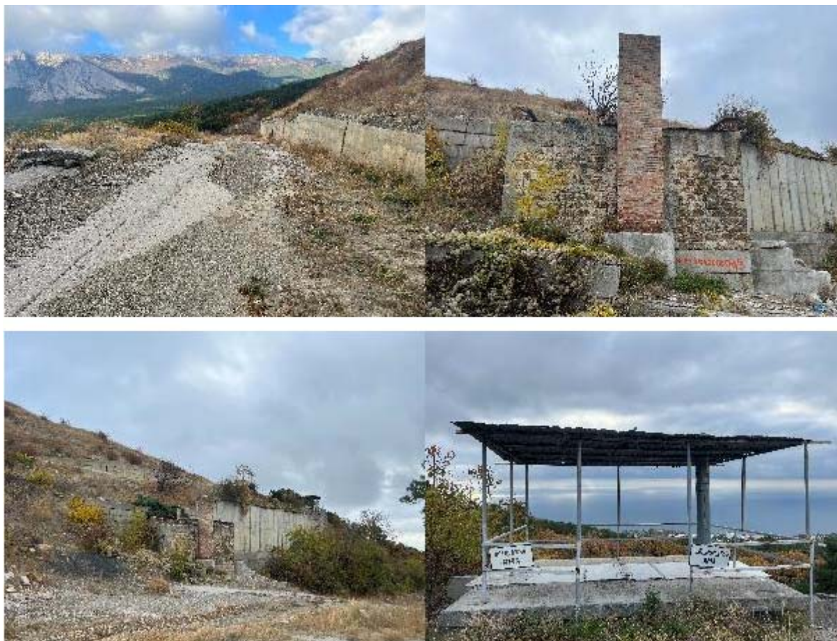
Рис. 1.2.9.2. Полигон и строения на его территории
