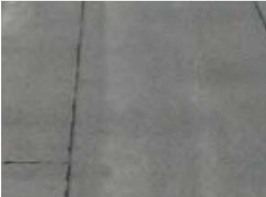
Рис. 3.4.4. Пример вытекшего битумно-полимерного связующего.
