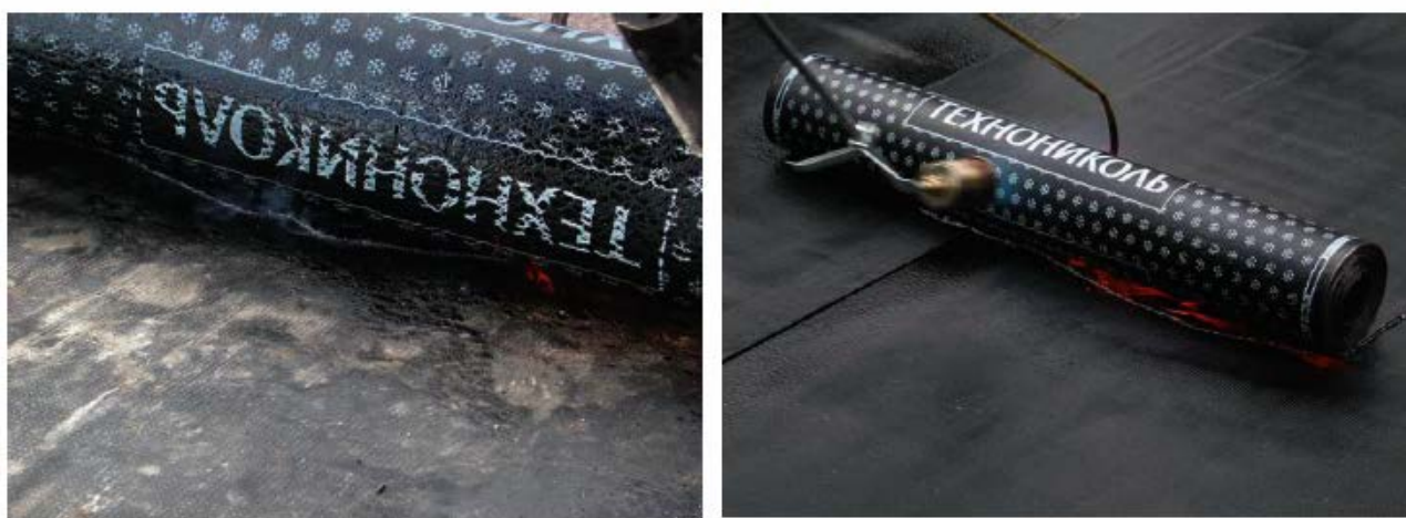
Рис. 3.4.3 валик расплавленного битумно-полимерного вяжущего.
