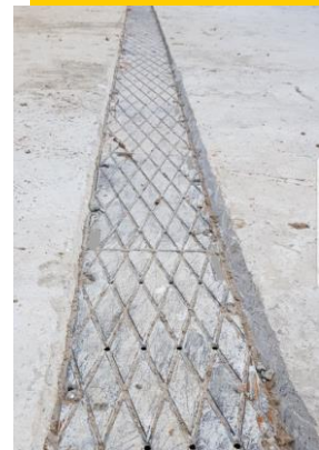
Каналы принудительной аэрации
