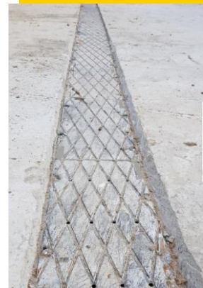
Каналы принудительной аэрации
