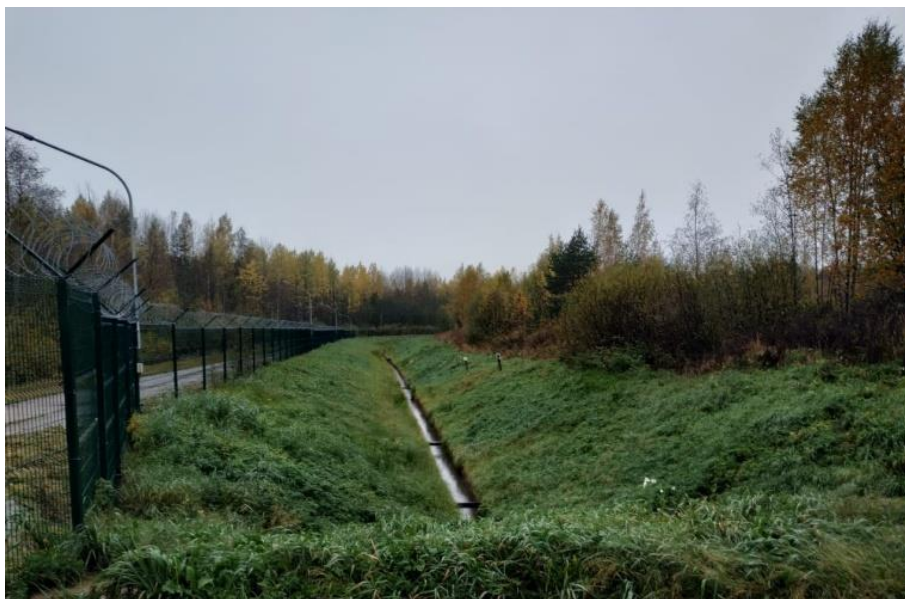
Рисунок 4.3. Дорога вдоль ограждения территории полигона.
