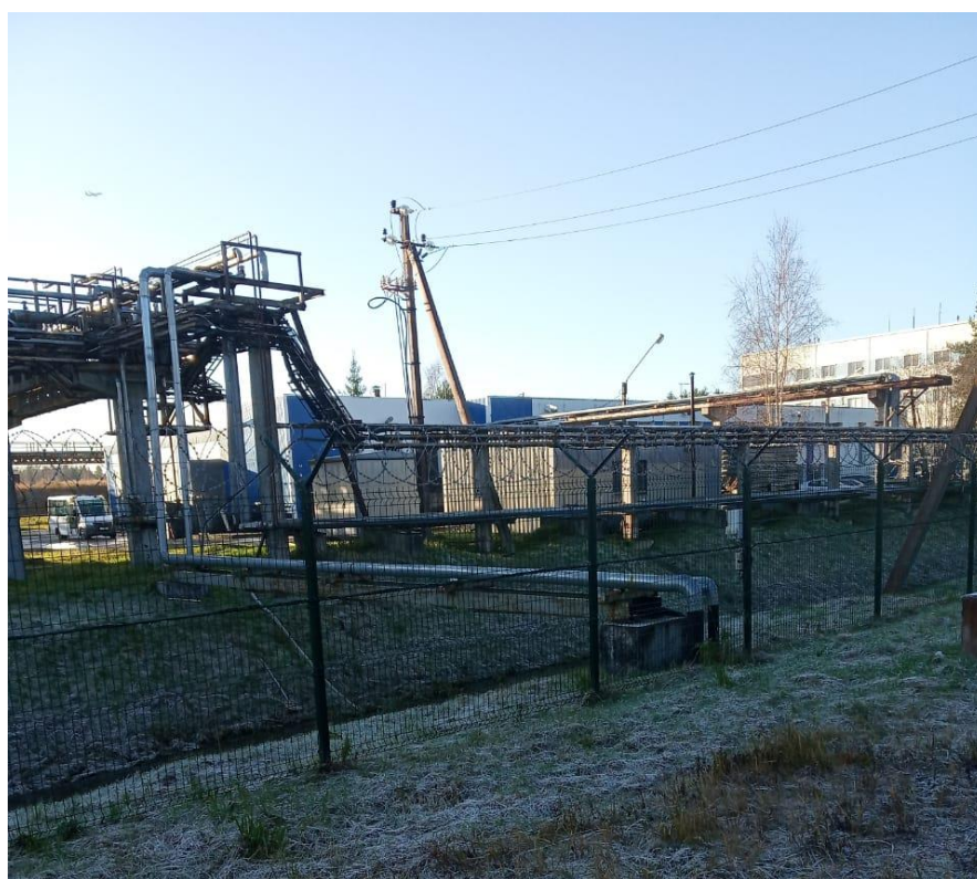
Рисунок 12. Существующая надземная прокладка труб водоотведения в зоне трассы ПФЗ.
