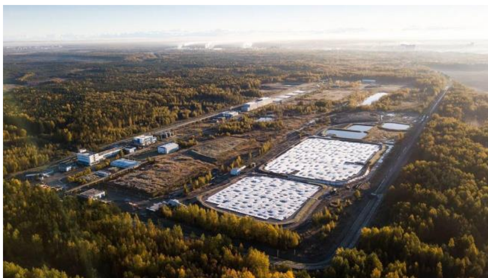
Рисунок 4. Карты полигона. На переднем плане карты №№68, 64 с временным геомембранным покрытием на понтонах.
