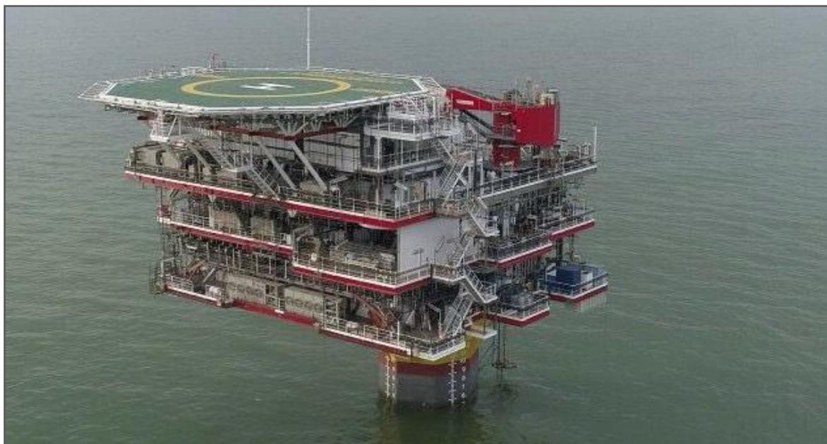
Рисунок 2.12. Внешний вид устьевого блока-кондуктора (БК)
