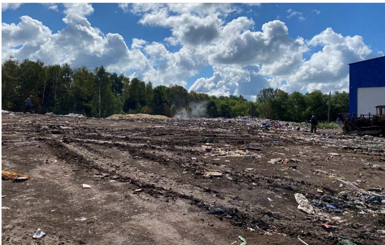
Рисунок 1.2.3. Территория объекта, вид с западной стороны
