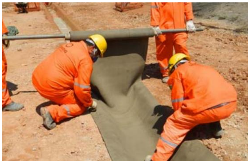
Рисунок 2.2 – Крепление бетонного полотна
