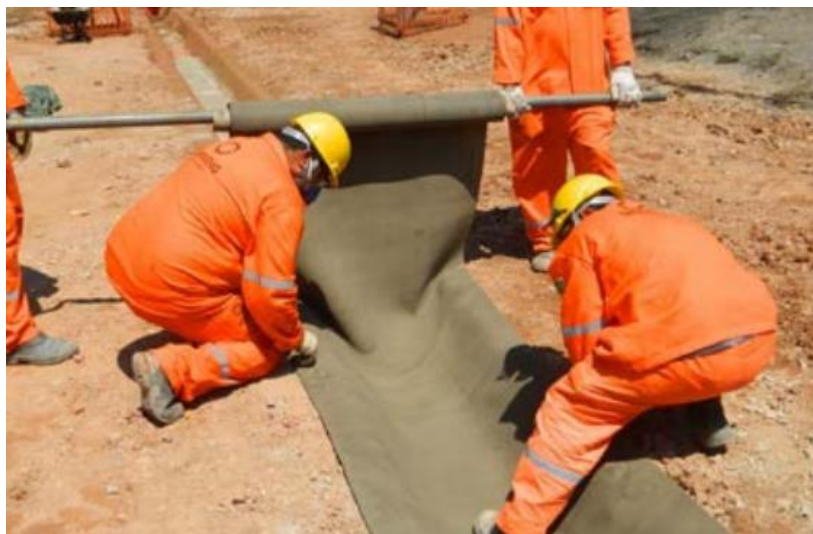
Рисунок 2.2 – Крепление бетонного полотна
