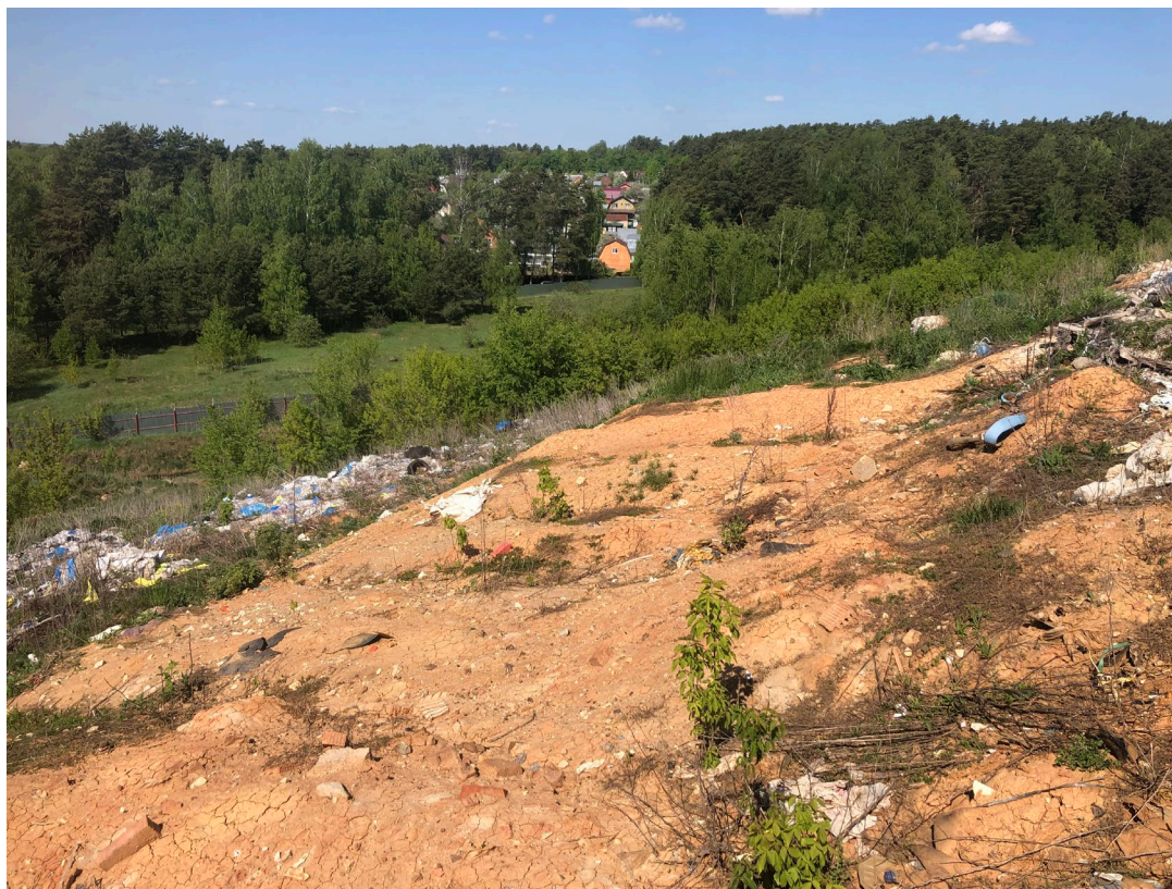
Фото 6 – Планировочная отсыпка поверхности и склонов тела полигона
