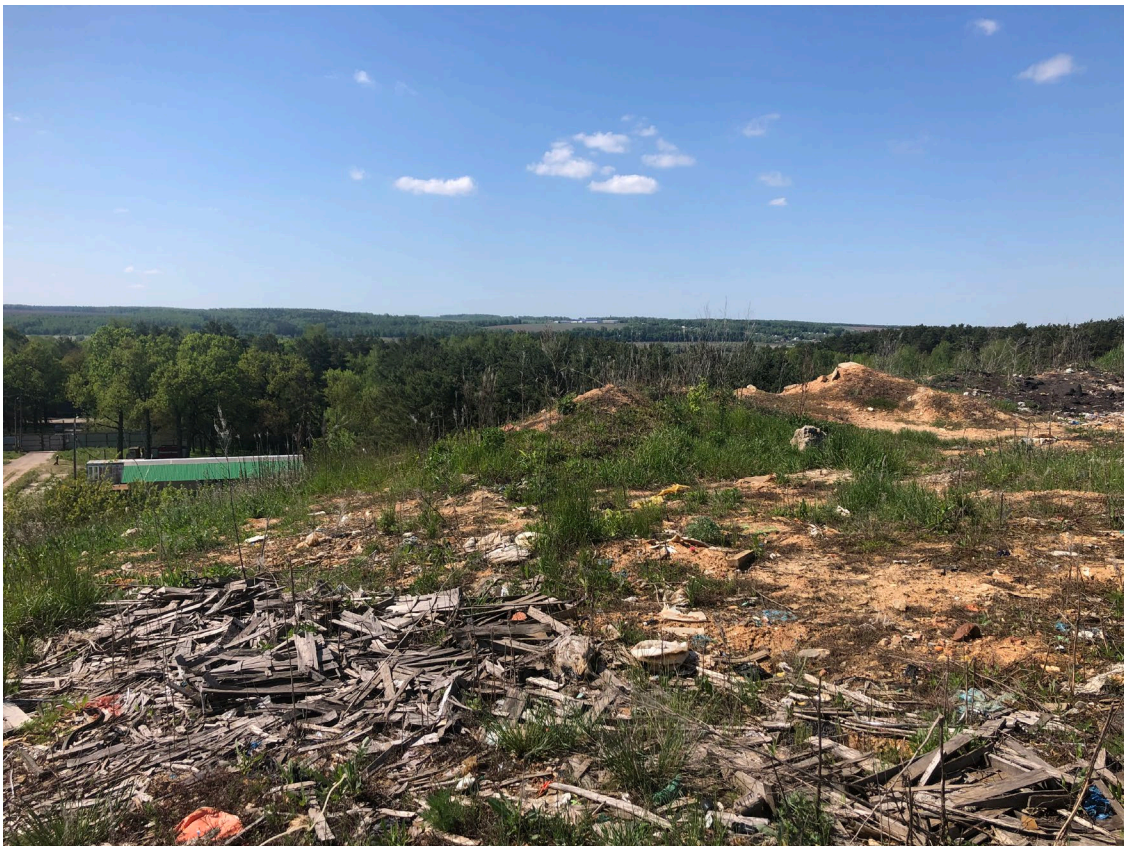
Фото 8 - Планировочная отсыпка поверхности тела полигона
