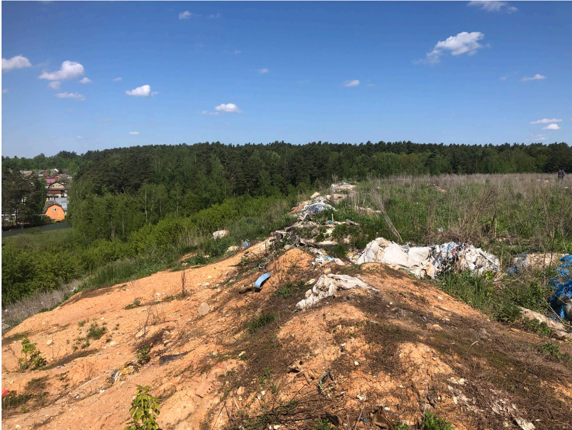
Фото 7 – Планировочная отсыпка поверхности и склонов тела полигона
