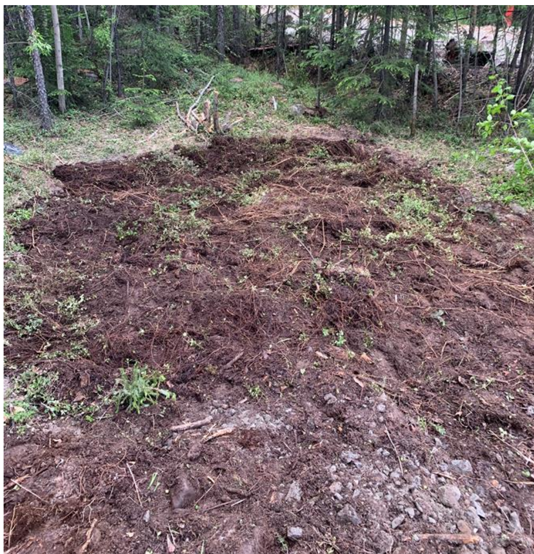
Рисунок 4.1.3.2-10. Формирование плодородного слоя поверх участков ОПИ
