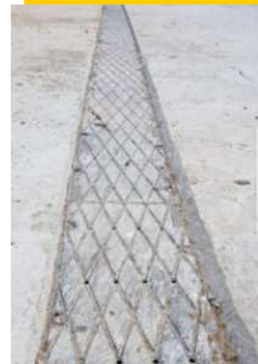
Каналы принудительной аэрации
