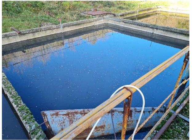
Рисунок 2.3 – Аэробные минерализаторы
