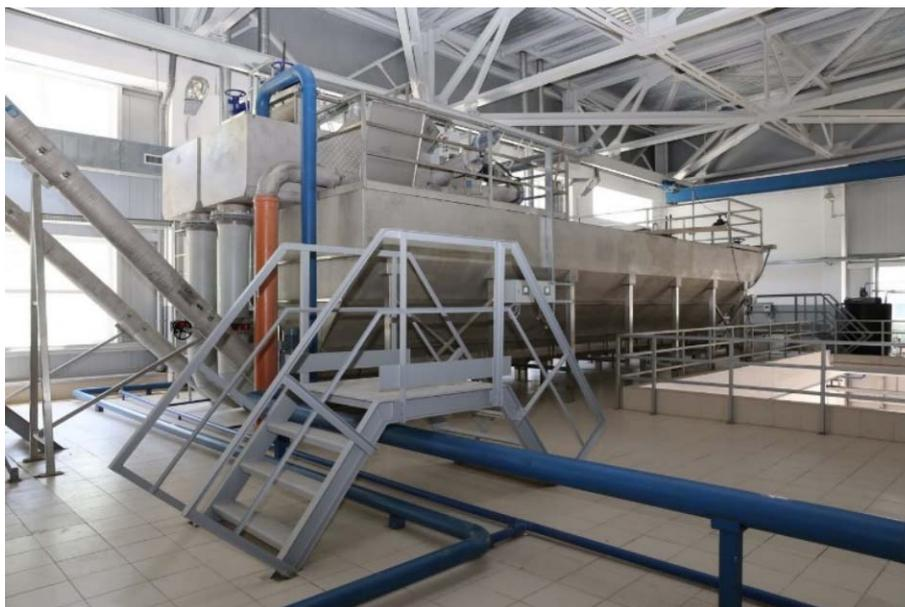
Рисунок 4.1.1 – Комбинированная установка механической очистки (пример)
