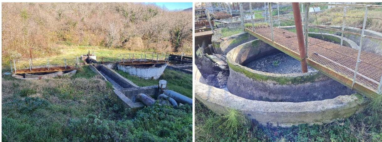
Рисунок 2.1 – Приемная камера и песколовки
