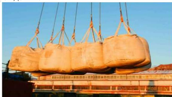
**Рис. 2.24.3 - «Подъём» состоит из восьми МК, подъёмные проушины которых навешаны на крюки рамы**
