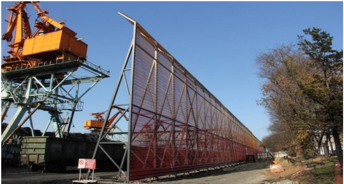
Рисунок 18.4.18 - Ветропылезащитные экраны причалов №№ 76-78
