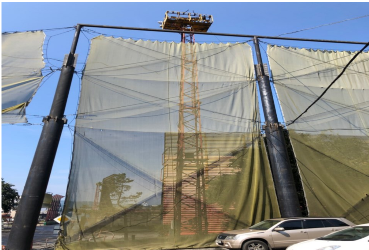
Рисунок 18.4.14 - Локальные ветрозащитные экраны в порту
