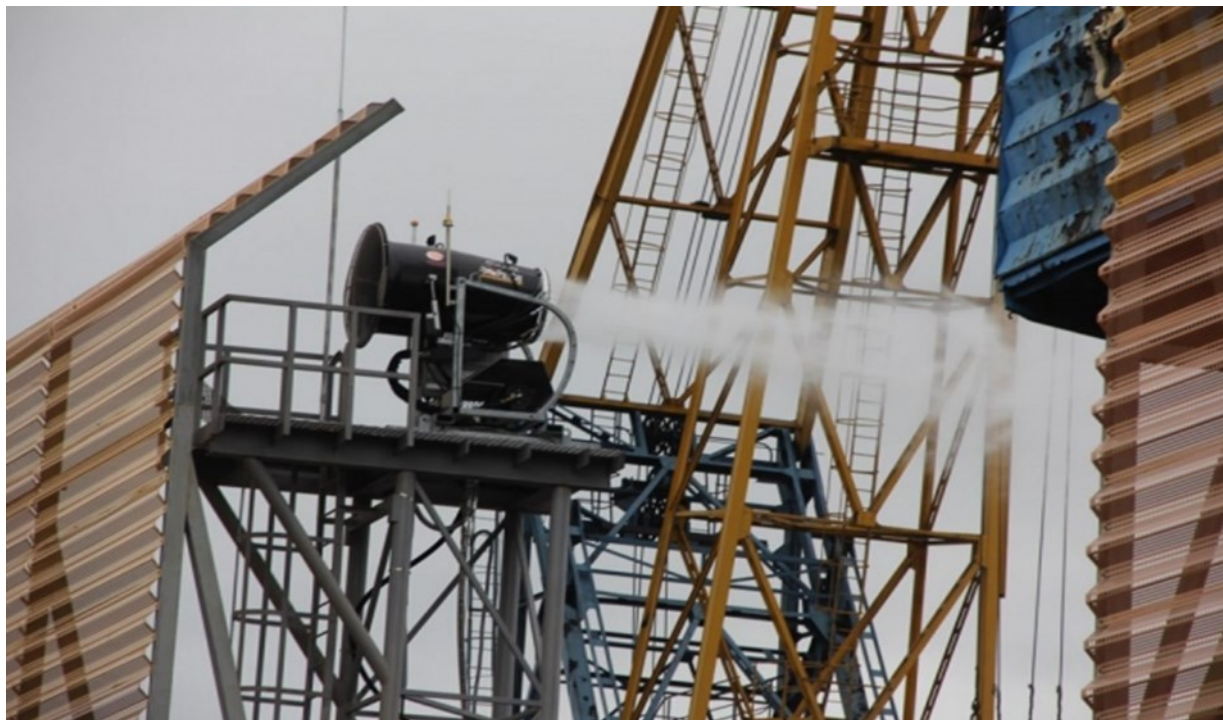
Рисунок 18.4.9 - Стационарные пушки Super PoleCat на причалах №№ 71-72
