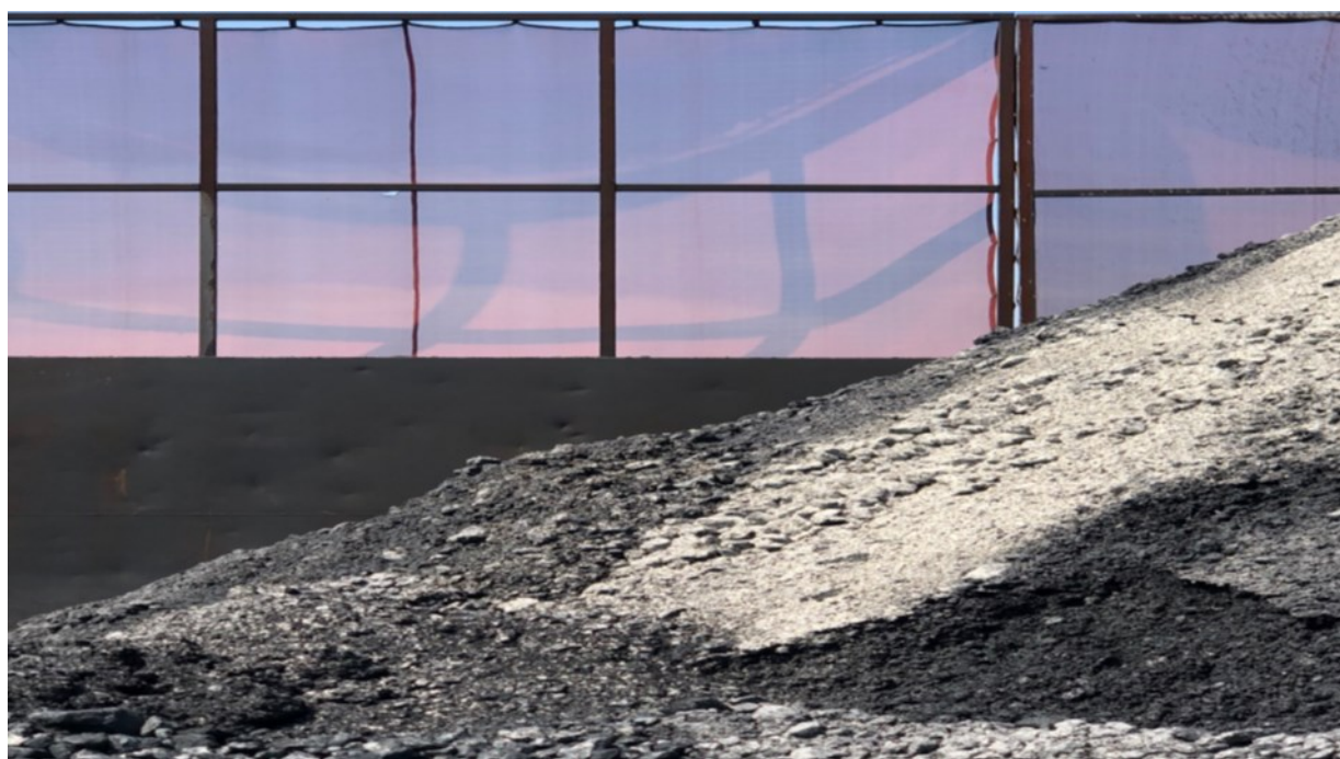
Рисунок 18.4.16 - Подпорная стенка, усиленная ветрозащитной сеткой
