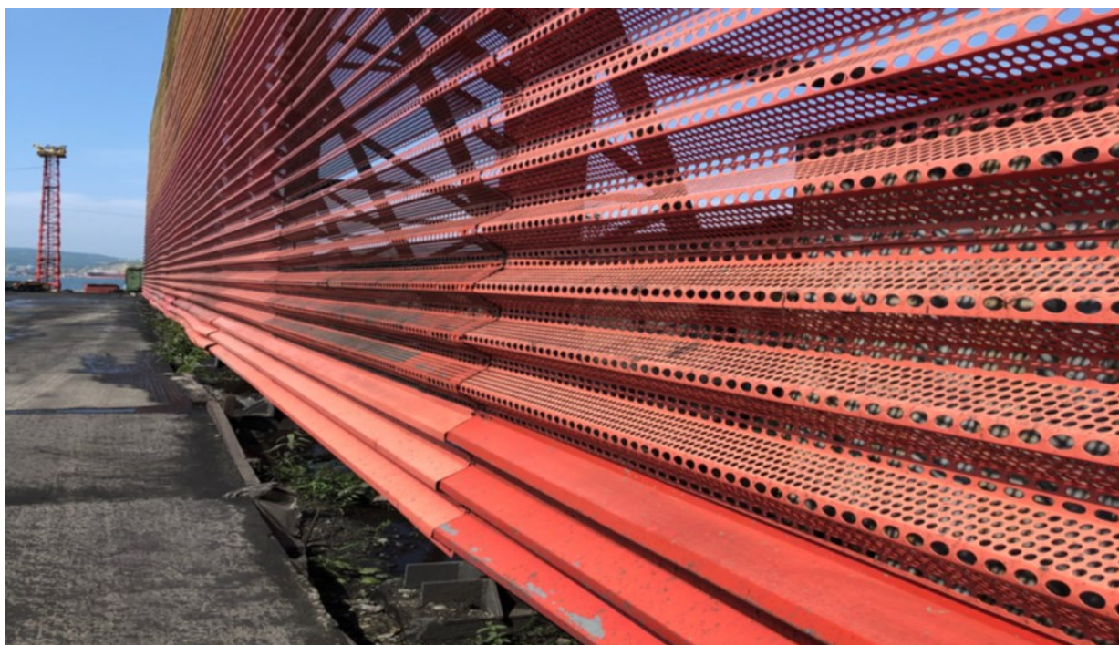
Рисунок 18.4.19 - Перфорированная стенка ветрозащитного экрана
