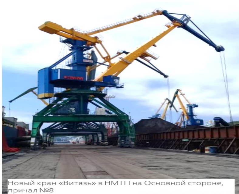
Рисунок 8.15 - Пример установленного портального крана на причале №8
