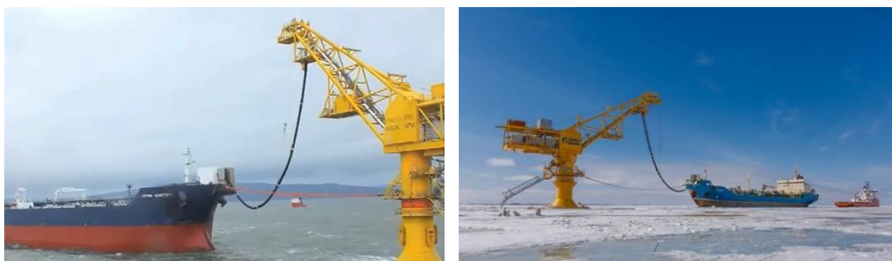
Рисунок 2.2. Выносное причальное устройство (ВПУ) в районе мыса Каменный
