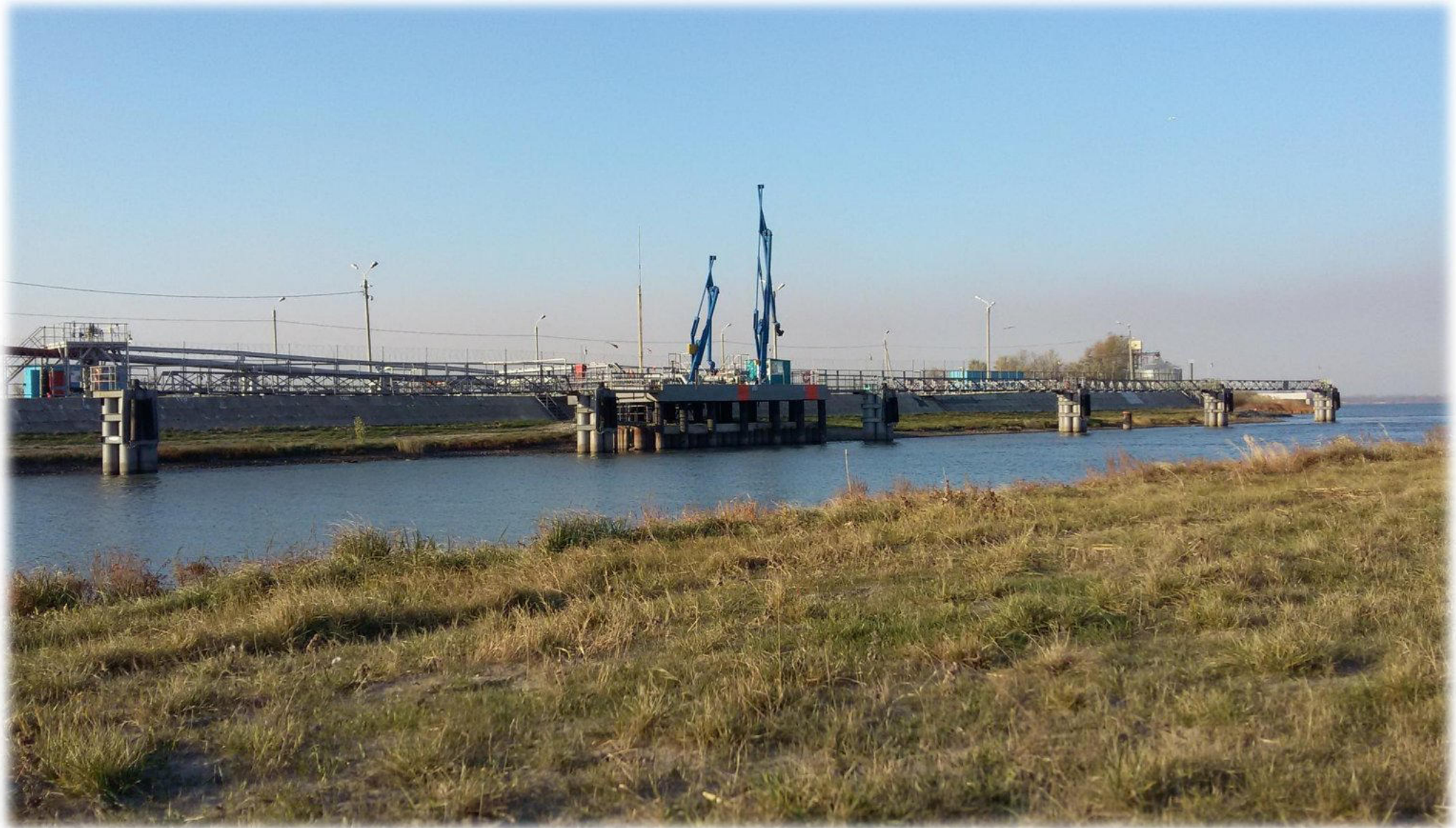
Причал №34. Общий вид (фото)
