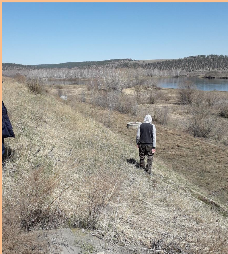
Низовой откос ограждающей дамбы. Смотровой колодец трубчатого дренажа
