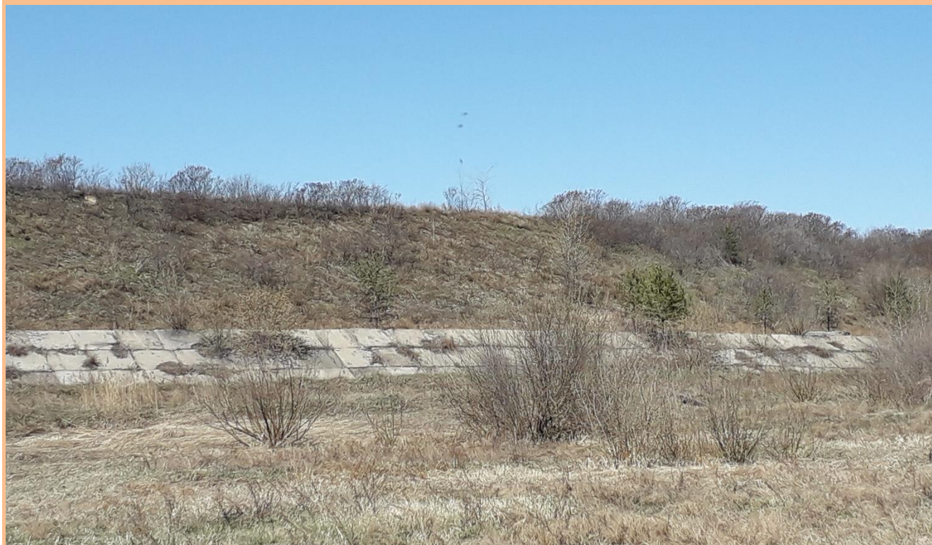
Низовой откос ограждающей дамбы. Смотровой колодец трубчатого дренажа
