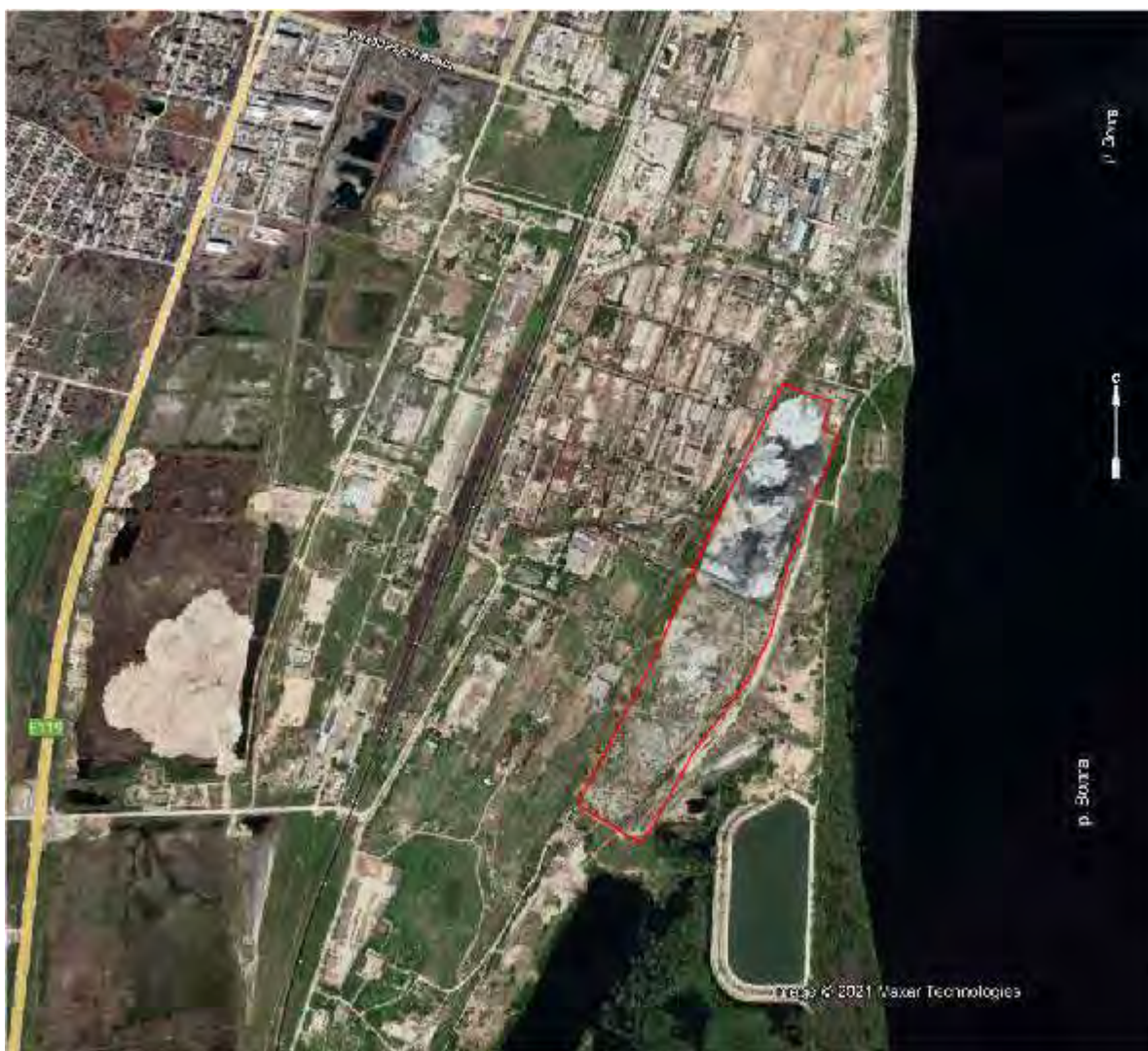
Рис. 1.1 Состояние шламонакопителя на 2021 год
