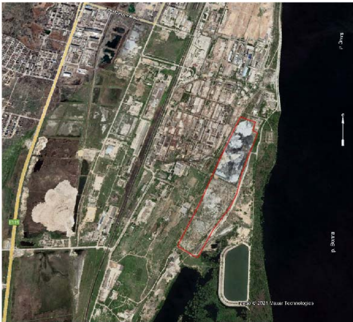
Рис. 1.1 Состояние шламонакопителя на 2021 год
