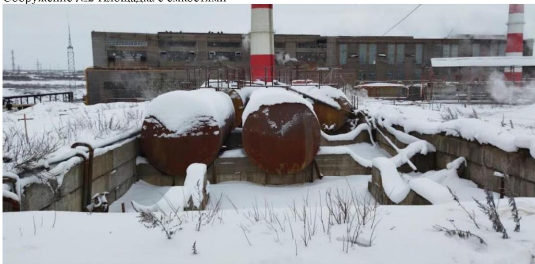
Сооружение №2 Площадка с емкостями
