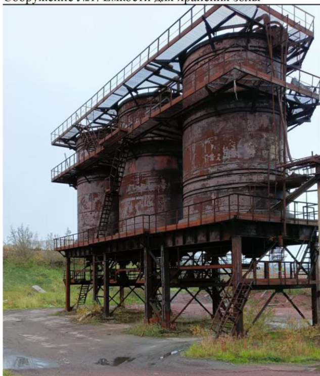
Сооружение №1. Емкости для хранения золы
