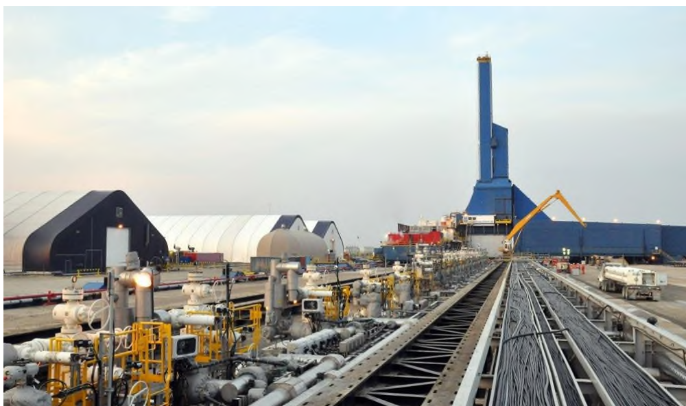
Рисунок 2-2: Буровая установка Ястреб и линия скважин
