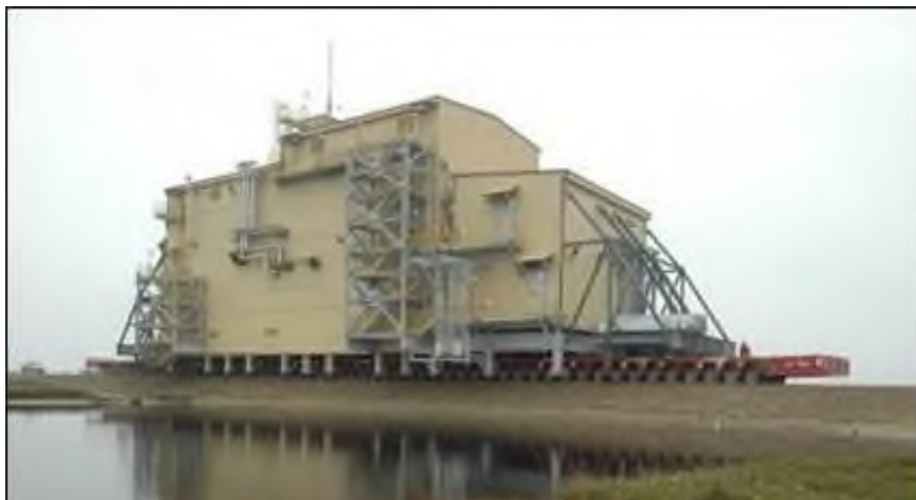
Рисунок 3.3-7: Горизонтальная разгрузка по типу РО-РО
