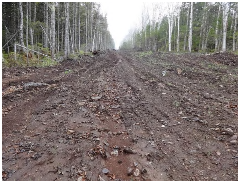
Рисунок 6.4-3: Линейная эрозия на расчищенном склоне
