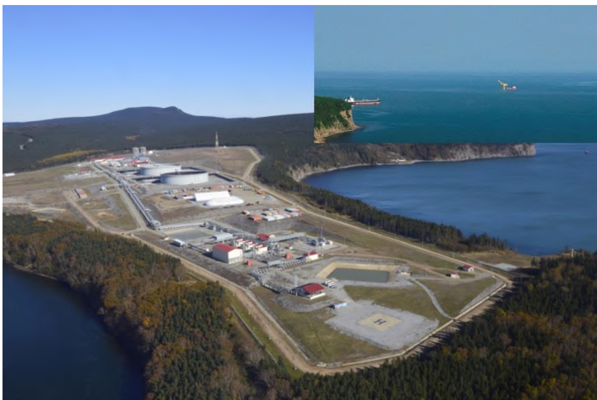
Рисунок 2-5: Общий вид (с юго-запада) береговых сооружений и нефтеналивного терминала НОТ Де-Кастри
