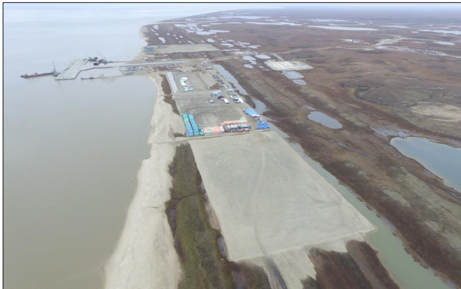
Рисунок 9.6.3: Морской тип местности. Поверхность заозеренной лагунно-морской лайды и причальные сооружения
