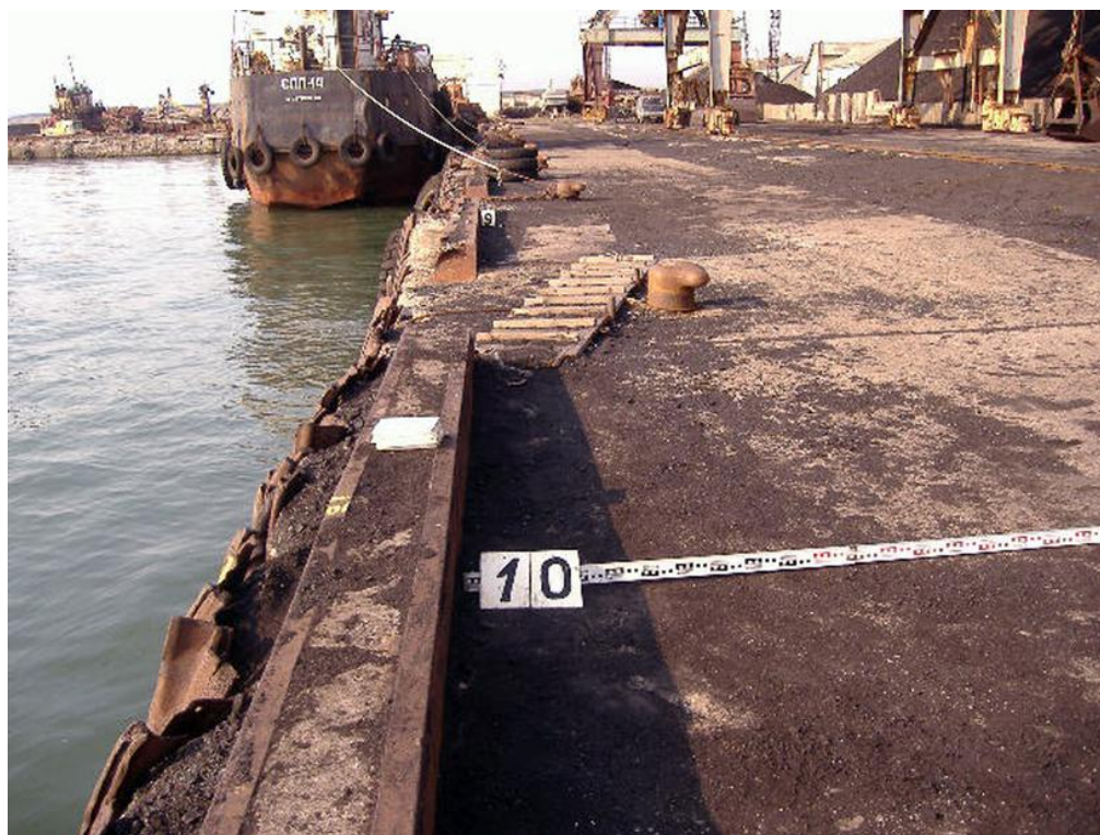
Фото 1. Причал №2. Общий вид.
