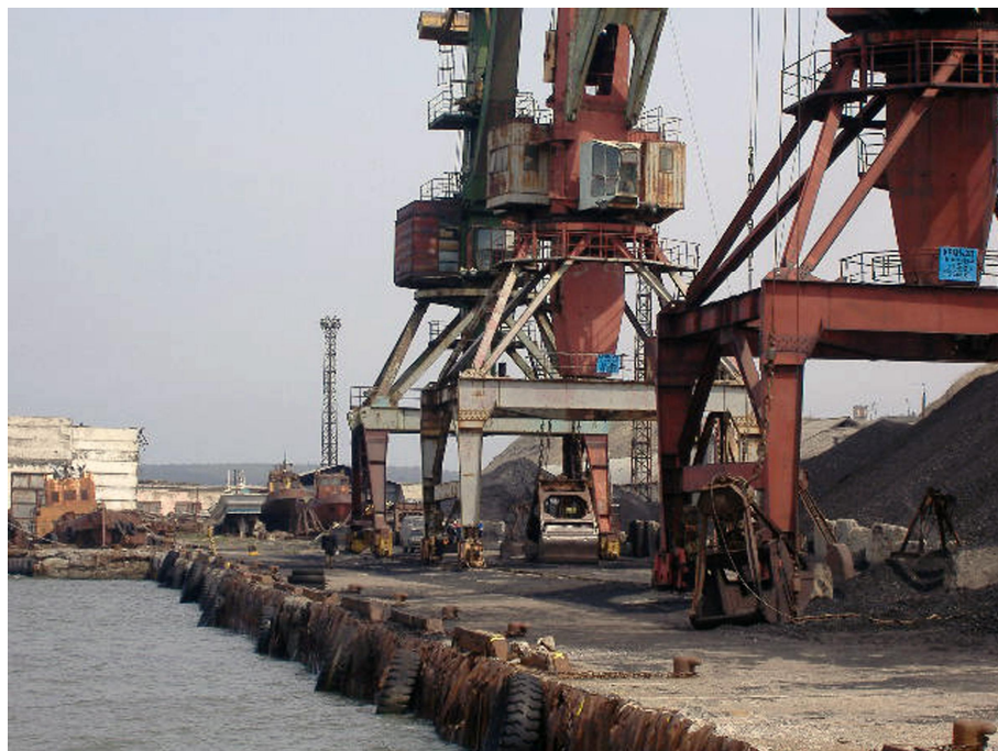
Фото 1. Причал №3. Общий вид.
