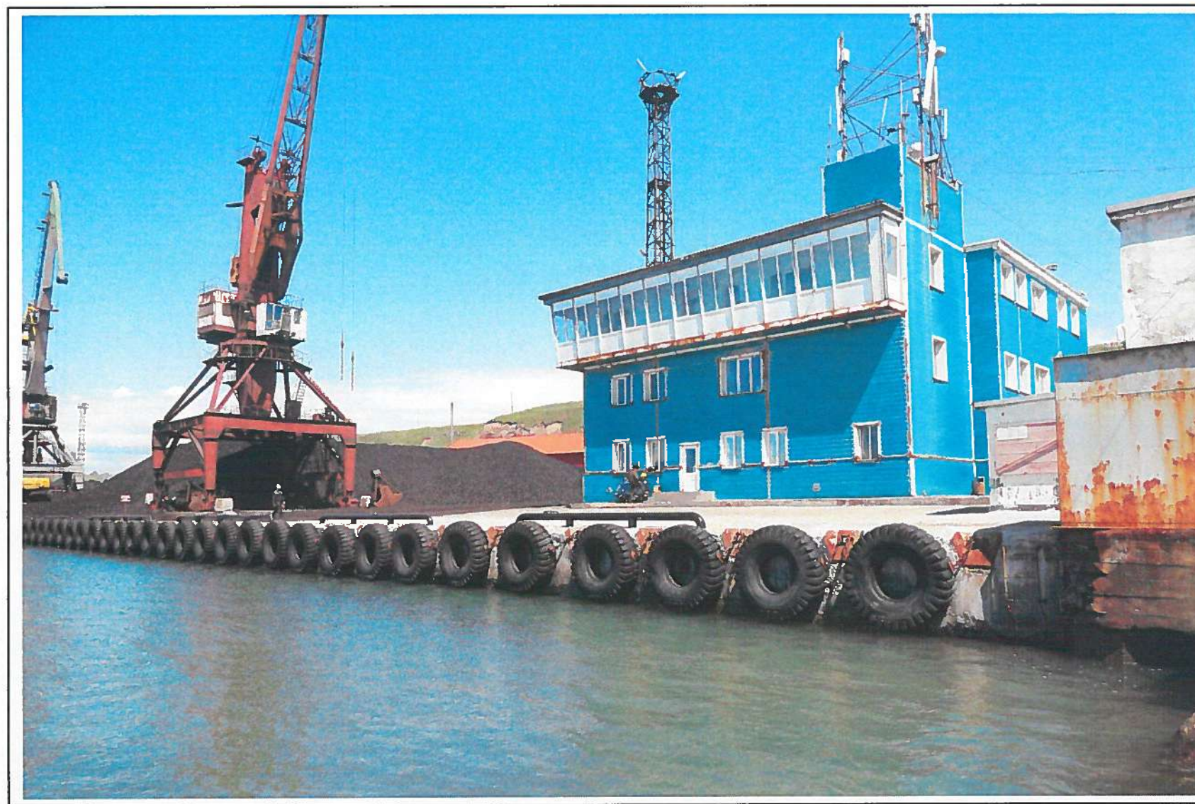
Общий вид причала №1.
