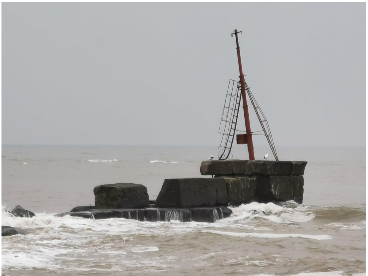
Рисунок 21. Мачта портового огня Западного мола - кПр(2)5с2М
