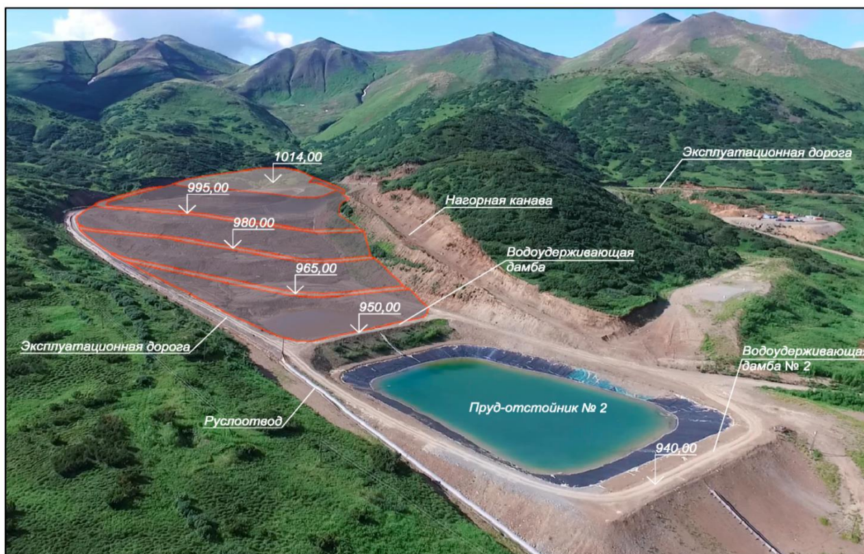
Рисунок 1.3 – Схема накопителя отходов обогащения ЗИФ (проектное положение)
