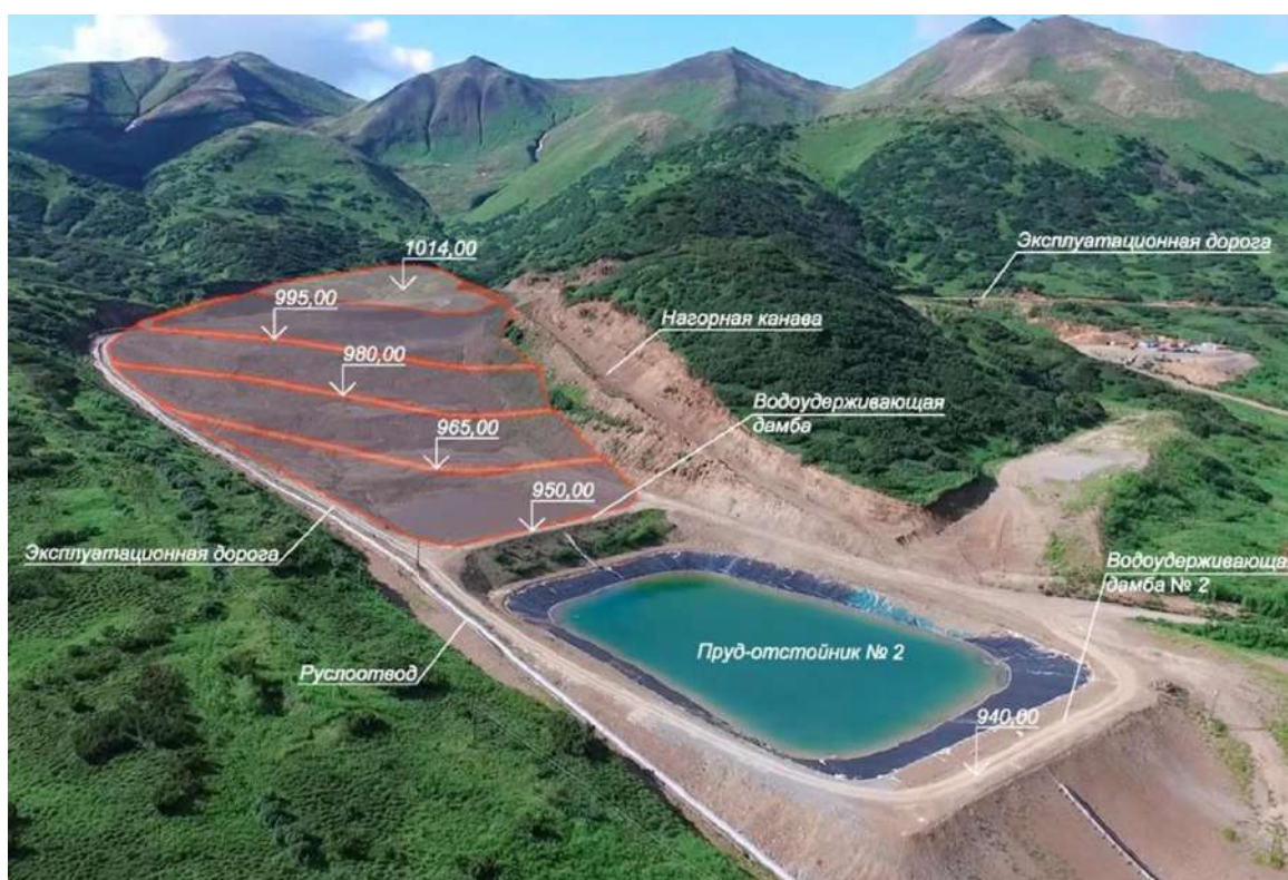
Рисунок 6.1 — Вид накопителя отходов обогащения золотоизвлекательной фабрики Агинского ГОКа» после складирования кека до финишной проектной отметки 1014,00 м.
