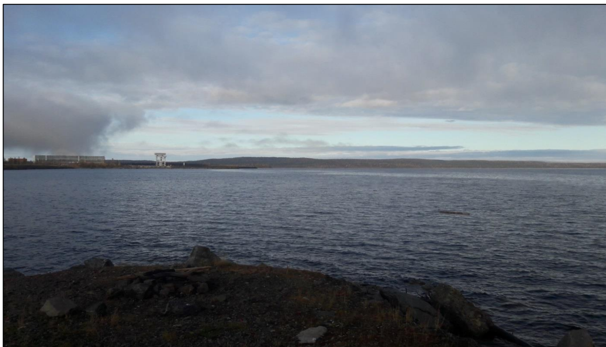
Р и с у н о к 2.5 – Водохранилище Курейской ГЭС. Вид на здание гидроузла и русловую плотину
