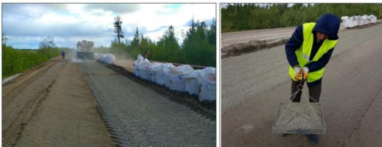
Рисунок 2.8 – Распределение цемента прицепным цементораспределителем а – распределение цемента по поверхности слоя грунта; б – метод контроля количества распределенного цемента
