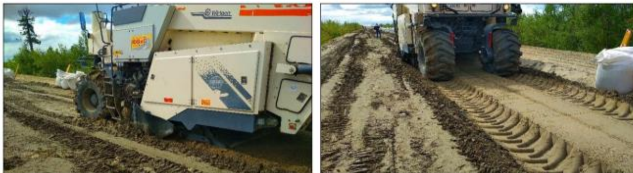
Рисунок 2.6 – Перемешивание песчаного грунта с обработанным буровым шламом
