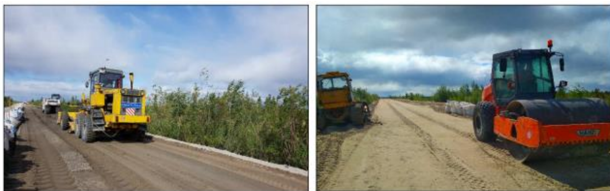
Рисунок 2.7 – Планировка смеси тяжелым автогрейдером и предварительное уплотнение
