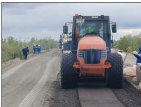
Рисунок 2.10 – Прикатка и планировка слоя из строительного грунта
