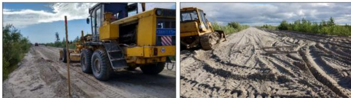
Рисунок 2.2 – Выполнение работ по планировке участка
