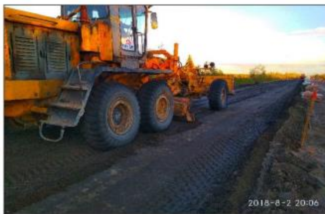
Рисунок 2.10 – Прикатка и планировка слоя из строительного грунта
