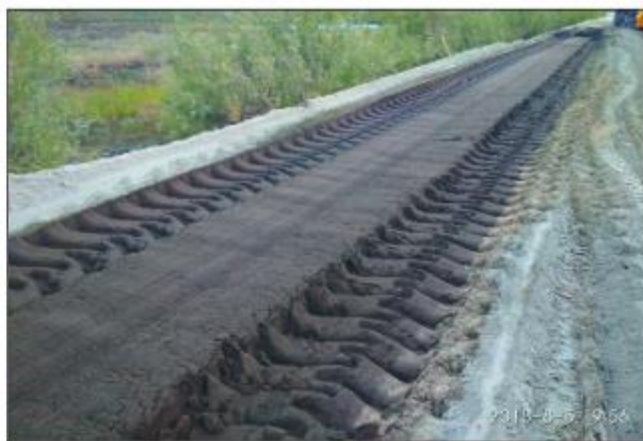
Рисунок 2.9 – Устройство слоя из строительного грунта «БРИТ»
