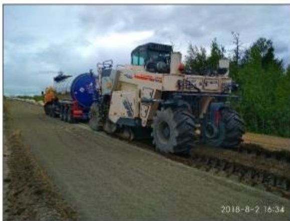
Рисунок 2.9 – Устройство слоя из строительного грунта «БРИТ»
