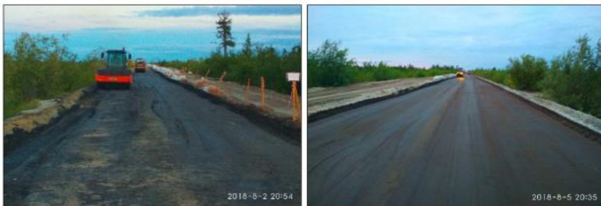
Рисунок 2.11 – Окончательное уплотнение слоя из строительного грунта «БРИТ»
