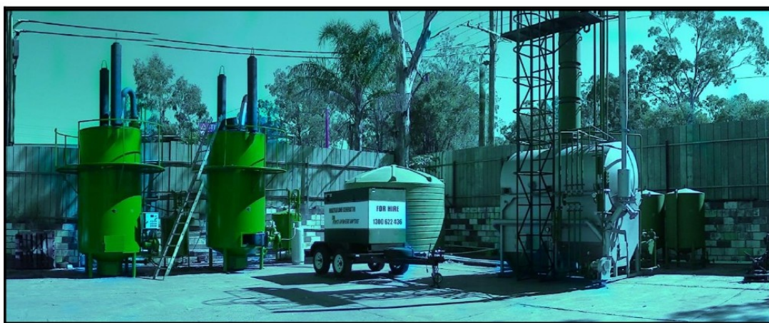
Установка пиролиза FORTAN x2 и Ректификационная колонна SARGAS-4, Брисбен, Австралия
