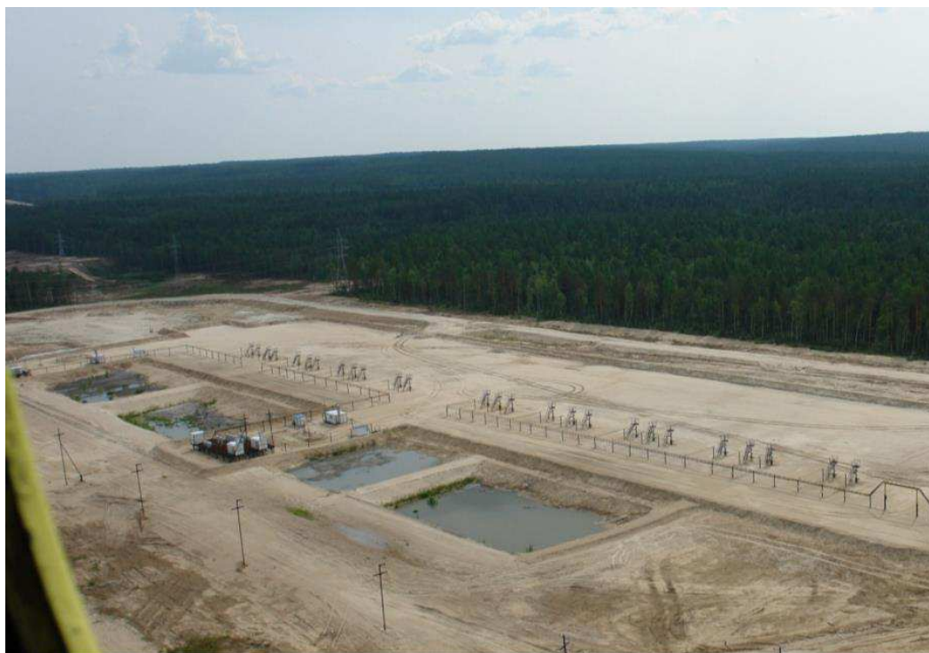
Рисунок 3 - ША после выполнения технических мероприятий по рекультивации
