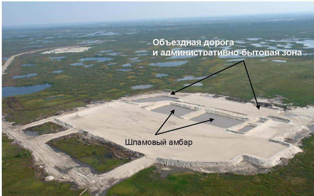
Рисунок 2 – Современная конструкция существующего куста скважин со ША
