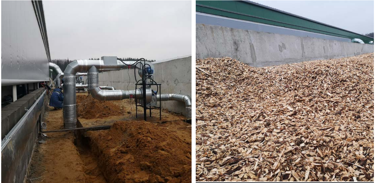
Рисунок 2.5 – Заполнение биофильтра и система вентиляции
