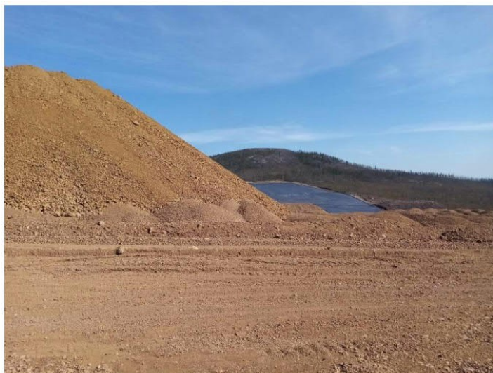
Рис. 1.32 Участок производства земляных работ на территории объекта изысканий
