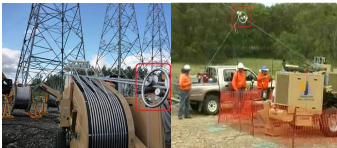
Рисунок 8.13 – Роликовое заземление на раскатываемом проводе
