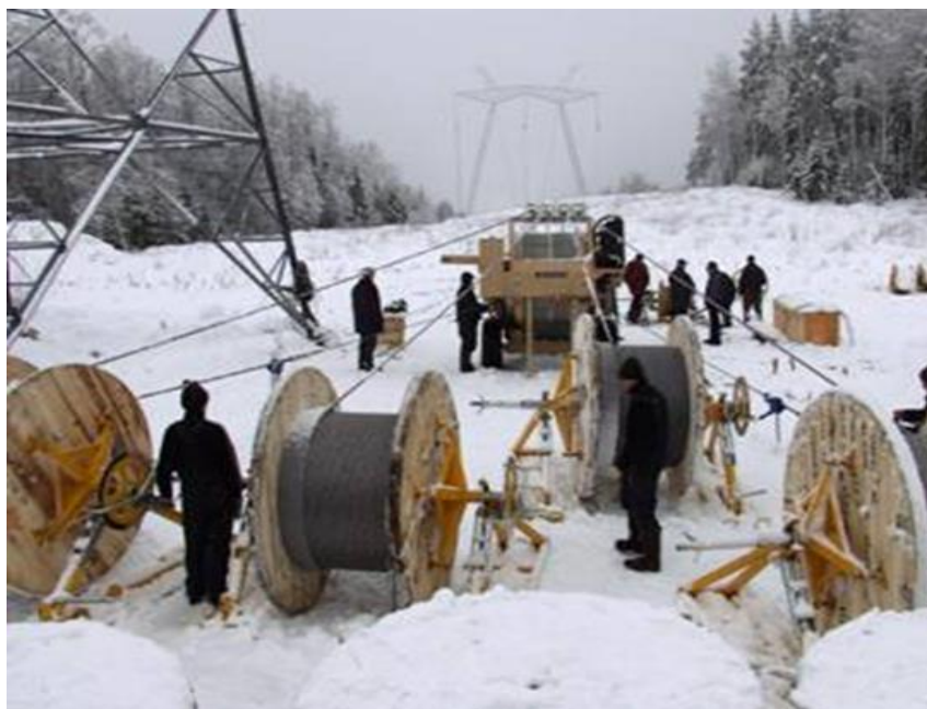
Рисунок 8.11 – Размещение оборудования в начале участка ВЛ
