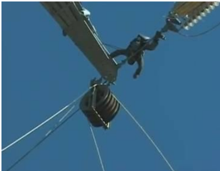
Рисунок 8.12 – Крепление раскаточного ролика к траверсе опоры
