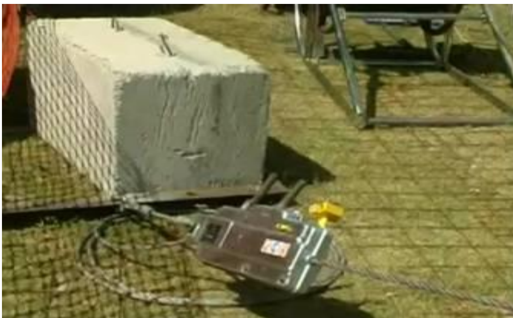
Рисунок 8.9 – Установка тормозной машины – временный якорь
