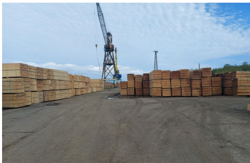
Рисунок 2.1 – Общий вид причала
