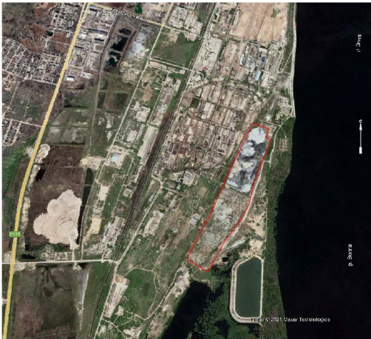
Рис. 1.1 Состояние шламонакопителя на 2021 год
