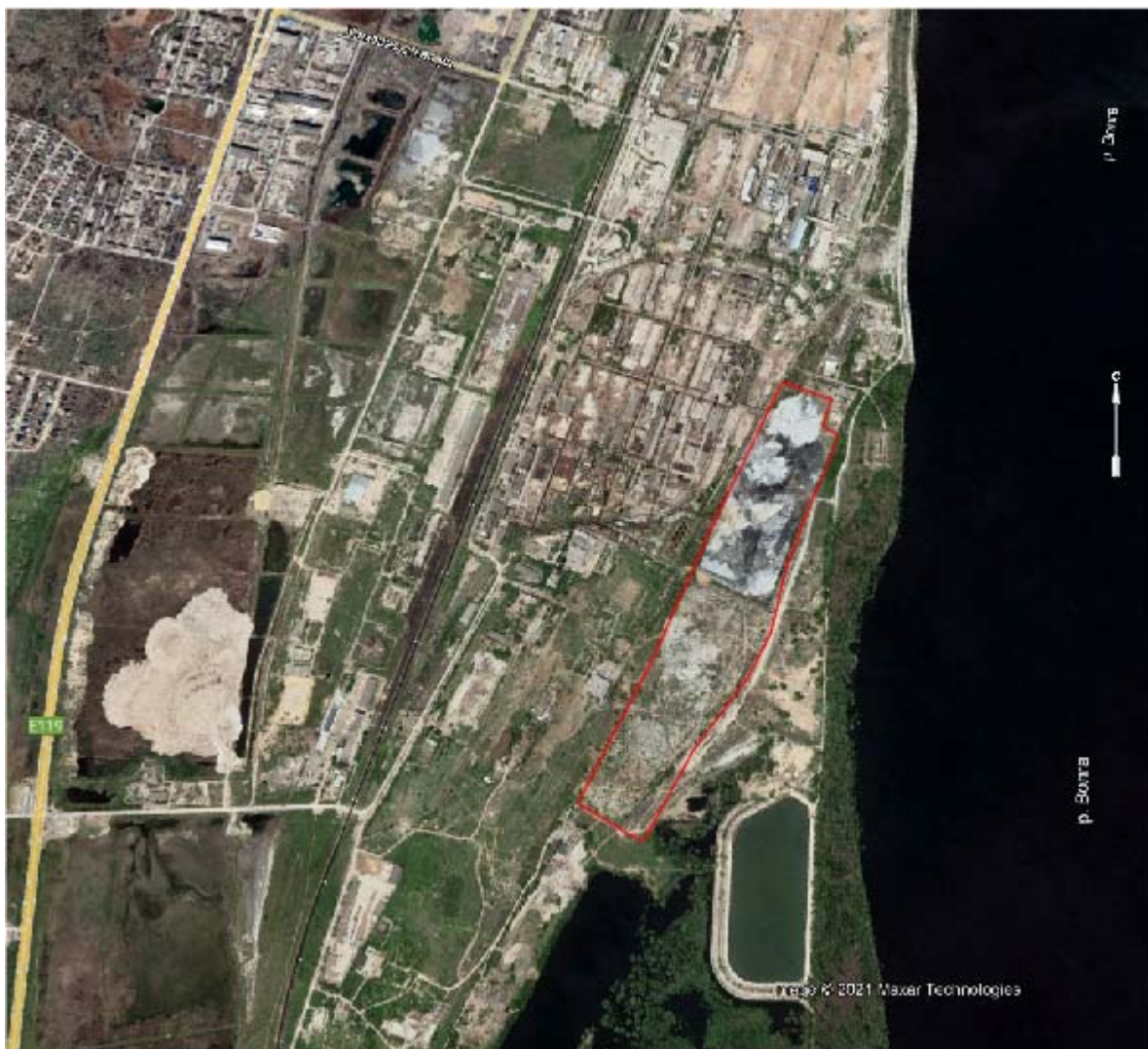
Рис. 1.1 Состояние шламонакопителя на 2021 год
