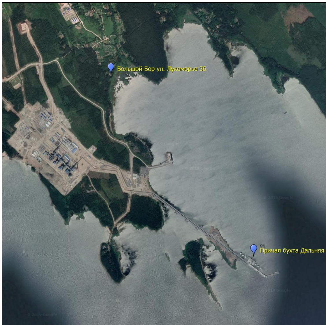
Рисунок 2.19. Местоположение терминала и причала отгрузки СПГ в районе КС «Портовая»
