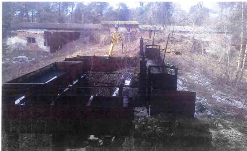
Двухъярусный отстойник (поз.03)
