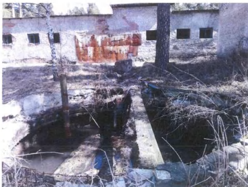
Вторичный отстойник (поз.05)
