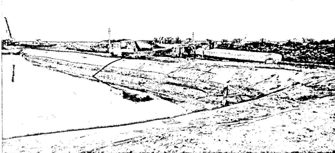
Рис. 2 Откачка БСВ из шламowego амбара скважины № 222
