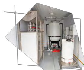
Вахтовый поселок Очистные сооружения Кингисепп, близ д. Ханике
