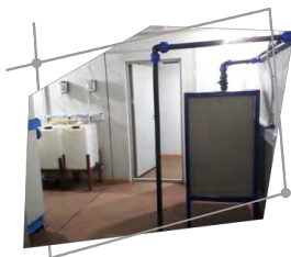
Порт Тамань, ж/д инфраструктура Очистные сооружения Краснодарский край
