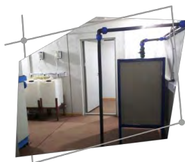
Порт Тамань, ж/д инфраструктура Очистные сооружения Краснодарский край
