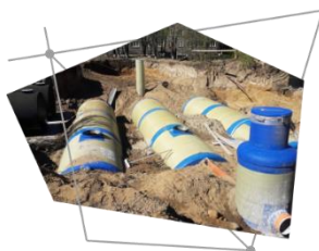
Краевая больница Хирургический комплекс Красноярск
