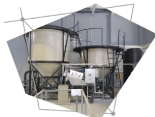
Электродепо «Южное» Очистные сооружения Санкт-Петербург
