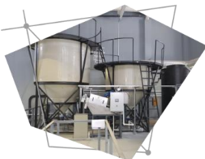
Электродепо «Южное» Очистные сооружения Санкт-Петербург
