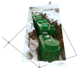
Комплекс по выращиванию шампиньонов Очистные сооружения Пензенская обл., г. Сердобск
