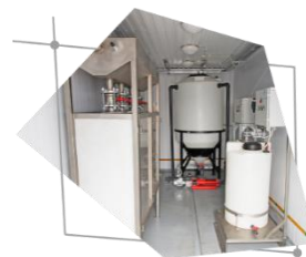
Вахтовый поселок Очистные сооружения Кингисепп, близ д. Ханике
