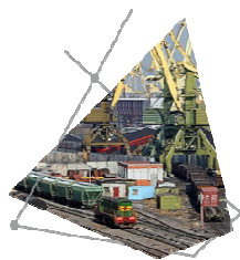
Терминал «Новая Гавань» Ленинградская обл.
