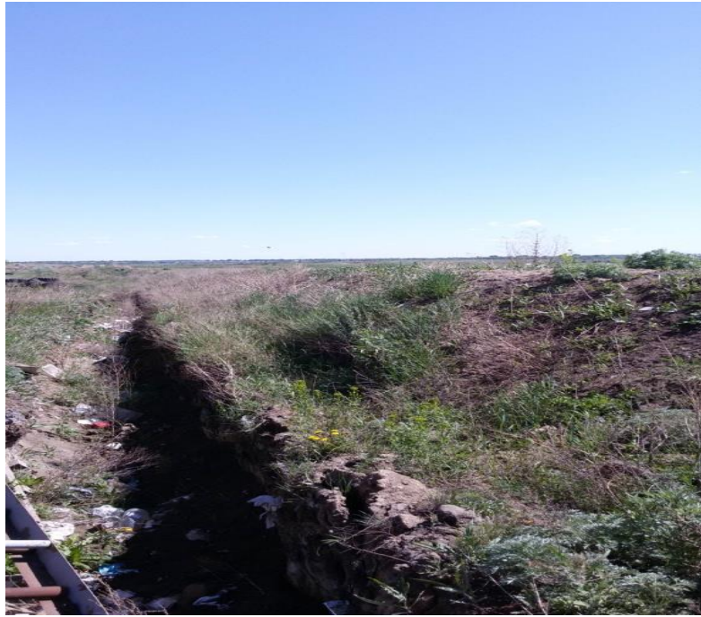
Фото 6.2 Рывина выполненная в естественных грунтах по периметру объекта
